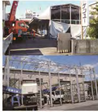
張り替え工事の様子(上下)
